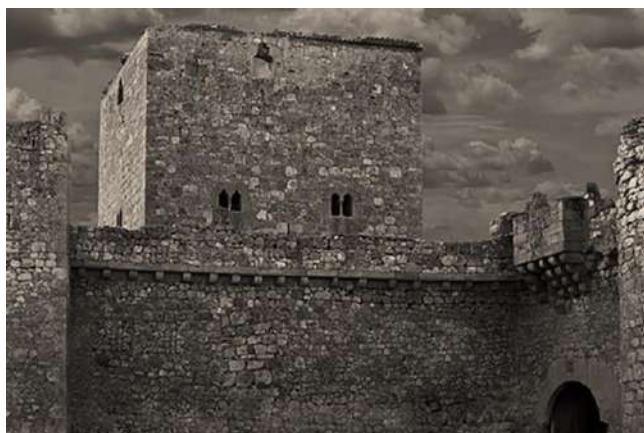
Fig. nº 128. Castillo de Santiago de la Torre (original, por J. Martínez).
