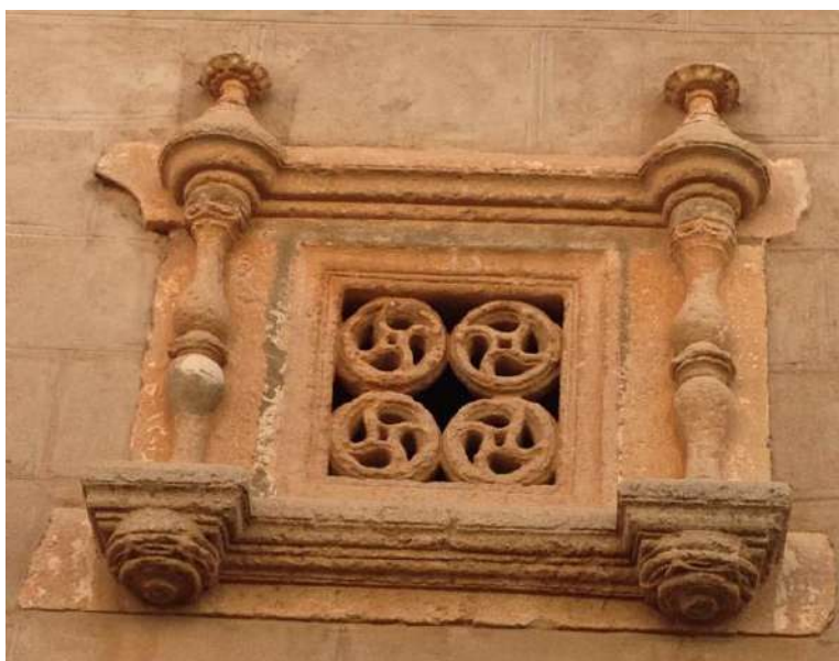
Fig. nº 165. Detalle de ventana con celosía, en San Clemente.
