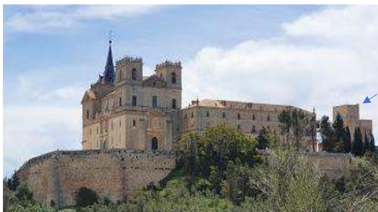
Fig. nº 28. Convento-Monasterio de Uclés (Sacristía, primera época constructiva. Foto 1): Cabeza de la Orden de Santiago, en 1174, " Caput Ordinis ". Sede de la Orden, desde 1230 (antigua torre de origen musulmán, derecha de la Foto 2).
