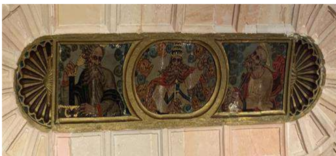
Foto 1. Techo de la Capilla.
