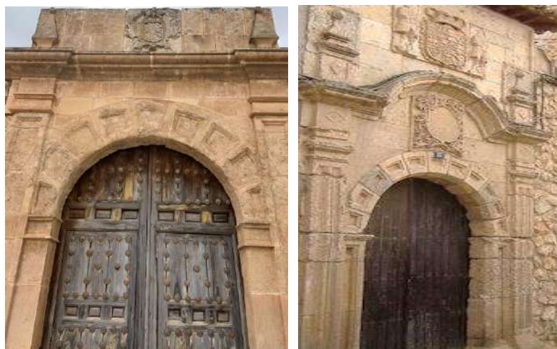
Fig. nº 200. Antiguo Hospital de San Andrés, en Belmonte 745 ; y Hospital de San Sebastián (también, fue puerta del Colegio de Jesuitas), en San Clemente, con anterioridad a 1520 746 (similitud de arcada de puertas).
