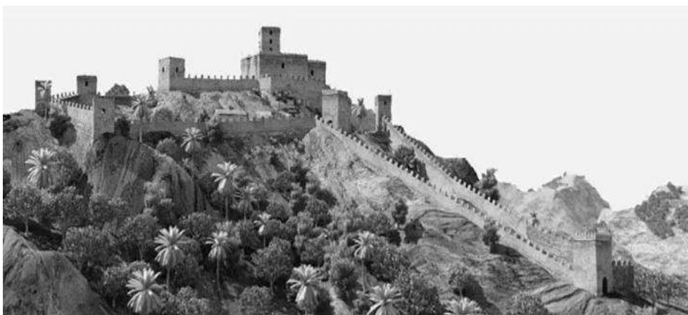
Fig. nº 108. CASTILLO DE RICOTE, antigua fortaleza de Ibn Hud 458 .
