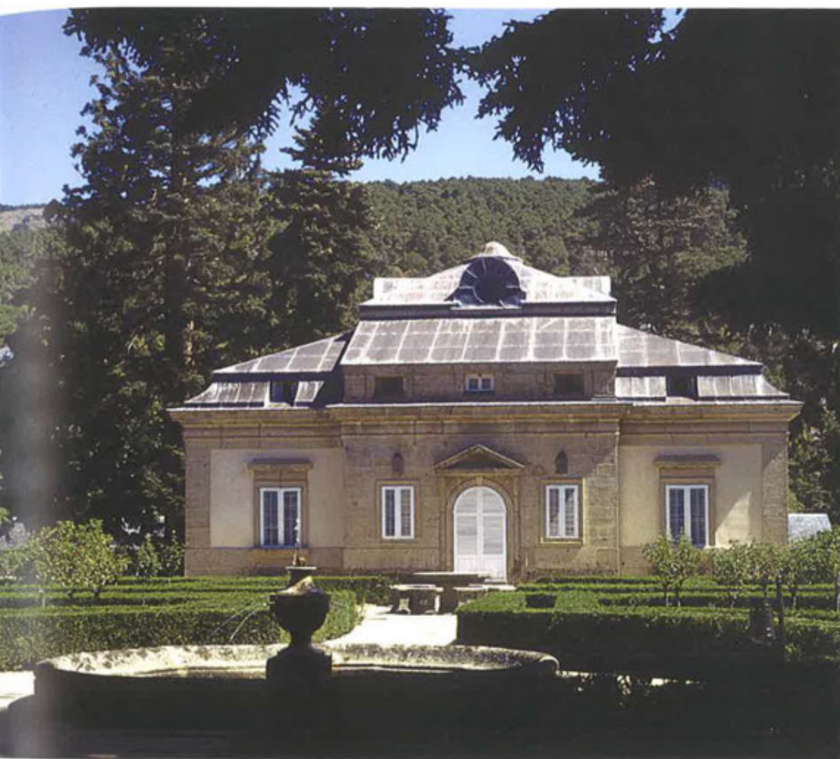
La Casita de Arriba o del Infante, construida entre 1771 y 1773 por el arquitecto Juan de Villanueva.
