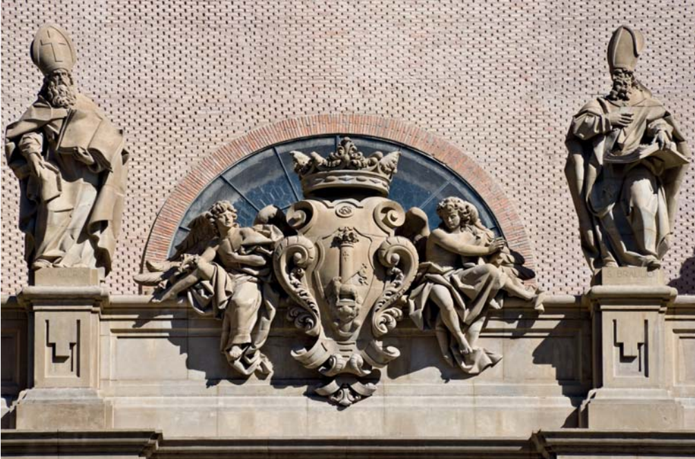
Fig. 17. Escudo del Cabildo Metropolitano de Zaragoza en el centro de la fachada principal de la basílica de Nuestra Señora del Pilar.
